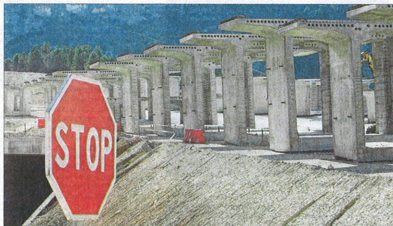
Las obras de la autovía central a su paso por Alcoy que impulsa el Ministerio de Fomento. / ERNESTO CAPARRÓS
